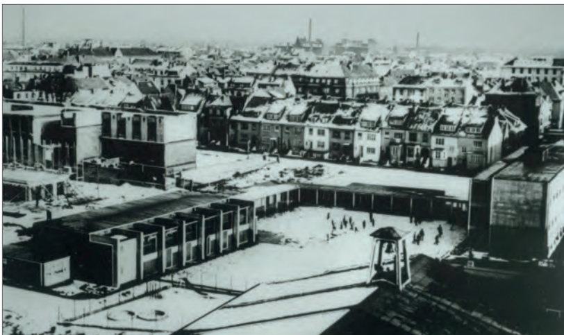
Baubeginn der Kaufmännischen Bildungsanstalten Ende der 50er Jahre (linke Bildmitte, davor die kriegszerstörte Ruine der alten Schule an der Hauffstraße, auf deren Fundament der heutige Trakt an der Hauffstraße steht)
