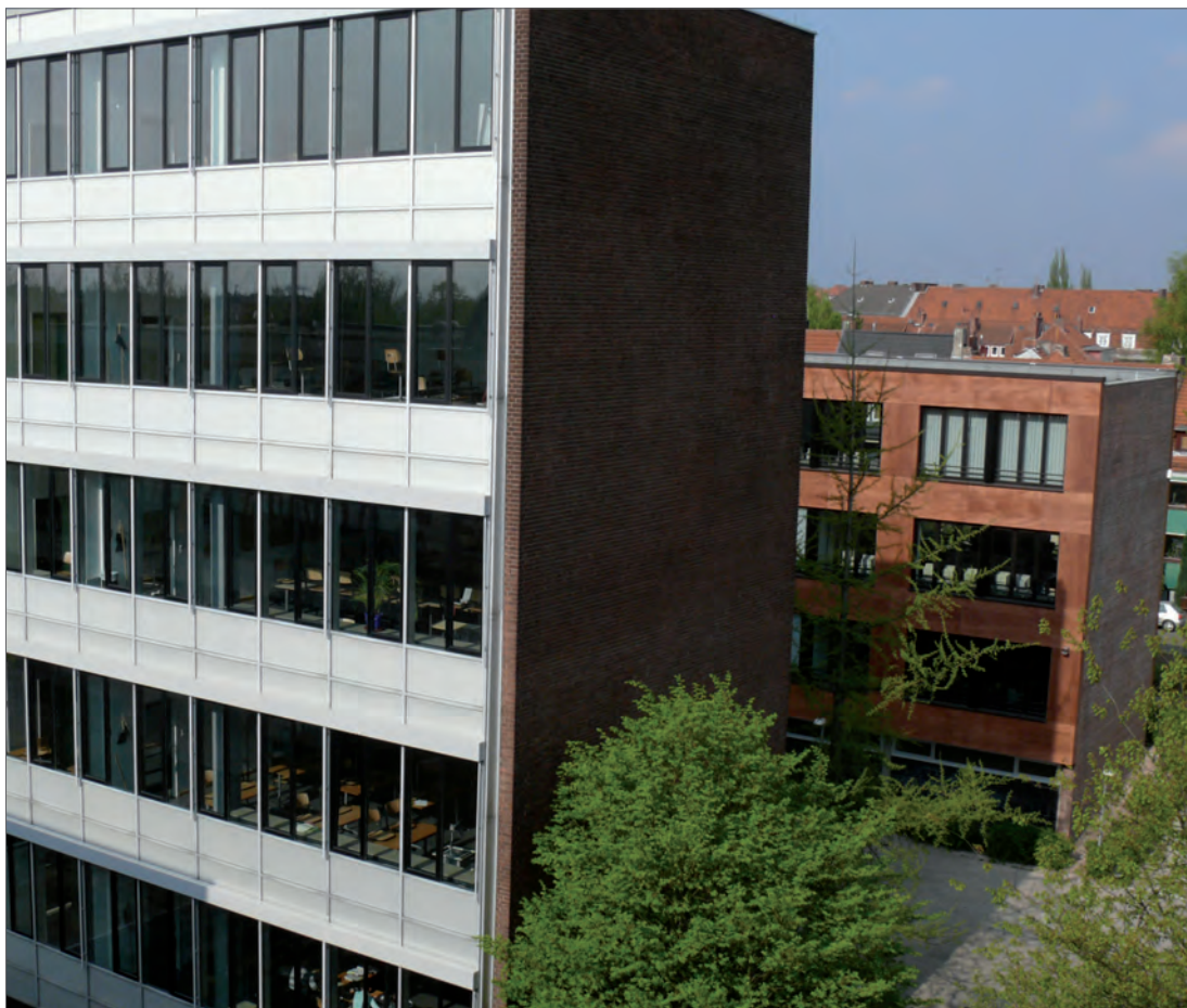
Die Fassadensanierung ist abgeschlossen (Aufnahmen 2009: Trakt Hauffstraße und mittlerer Trakt)
