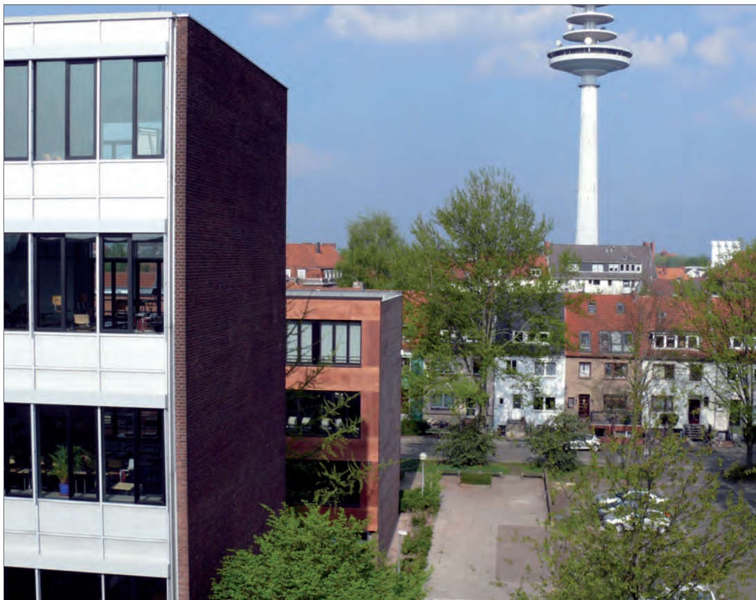
Die Fassadensanierung ist abgeschlossen (Aufnahmen 2009: Trakt Hauffstraße und mittlerer Trakt)
