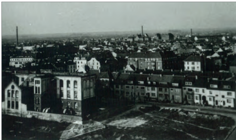
Die kriegszerstörte Ruine der alten Schule an der Hauffstraße in den 50er Jahren, auf deren Fundament heute der sogenannte Hauffstraßentrakt steht.
