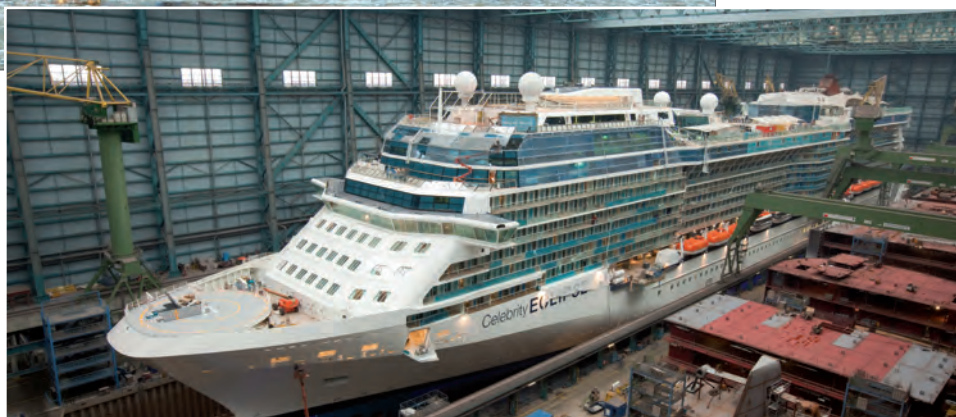
Überdachtes Baudock 1 Halle: 370 m x 101,5 m x 60 m Dock: 358 m x 39 m Überdachtes Baudock 2: Halle: 375 m x 125 m x 75 m Dock: 362 m x 45 m
