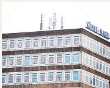
Dieser Schriftzug wurde in der vergangenen Woche am Kühne + Nagel-Haus angebracht.
